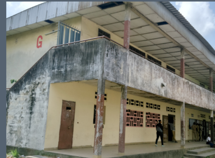
Lycée Municipal de Koumassi. Avant réhabilitation
