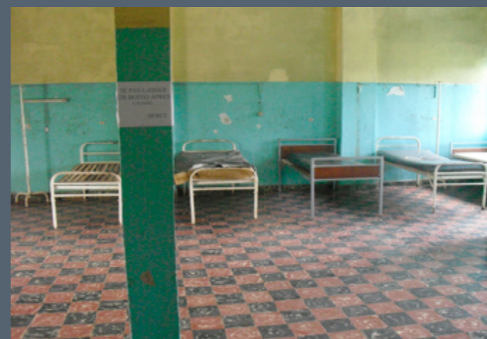
Salle de suite de couche (maternité de Bingerville) avant réhabilitation
