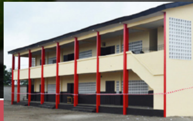
EPP Aliodan BAD de Marcory Anoumabo Après réhabilitation
