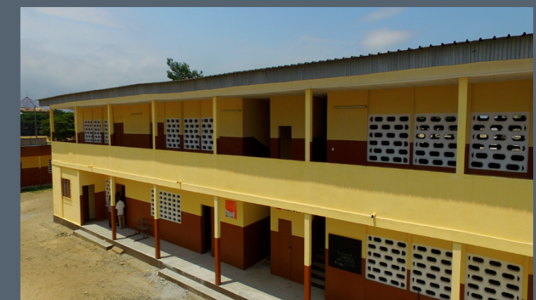
Après la réhabilitation du groupe scolaire Dion Robert par la FATOM
