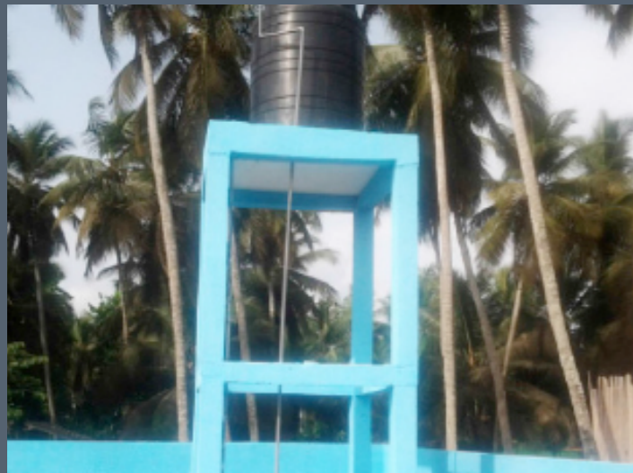
Construction d'un puits motorisé au CSU d'Assinie France.
