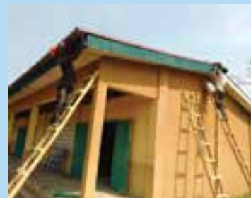
Les travaux de réhabilitation en cours.
