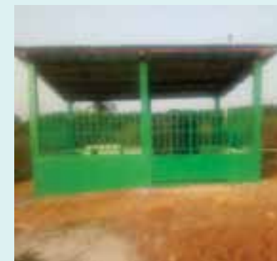
Une vue de l'abri du suppresser installé au lycée vert de Godiabré (Gagnoa).
