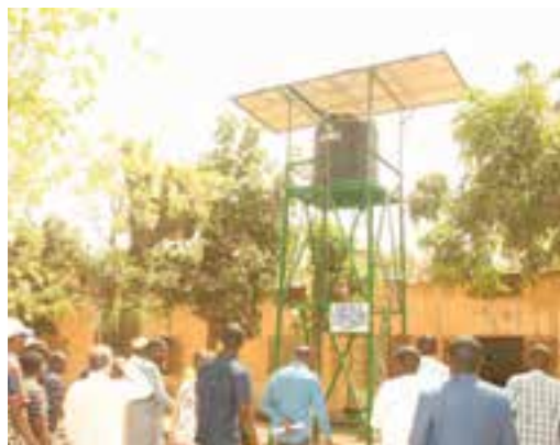
Construction du forage et du château d'eau à Dinguina Coulibaly.
