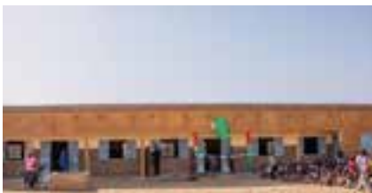
Une Vue du bâtiment construit.
