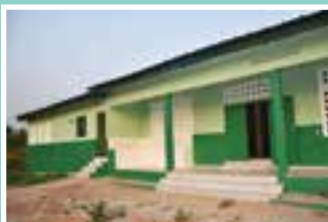
Façade avant de la cantine
