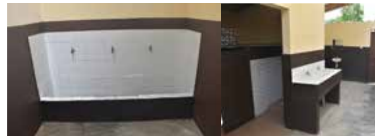
Construction de Toilettes, urinoirs et lave-mains à l'EPP ONO 4
