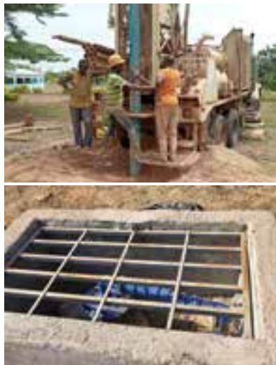
Construction d'un forage à la maternité du Centre de Santé Rural de Guibéroua.
