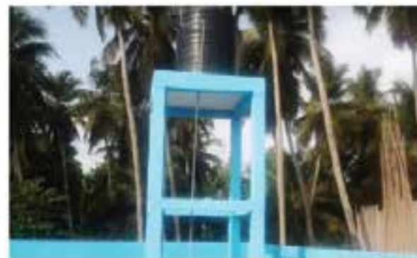
Construction d'un puits motorisé au CSU d'Assinie France.
