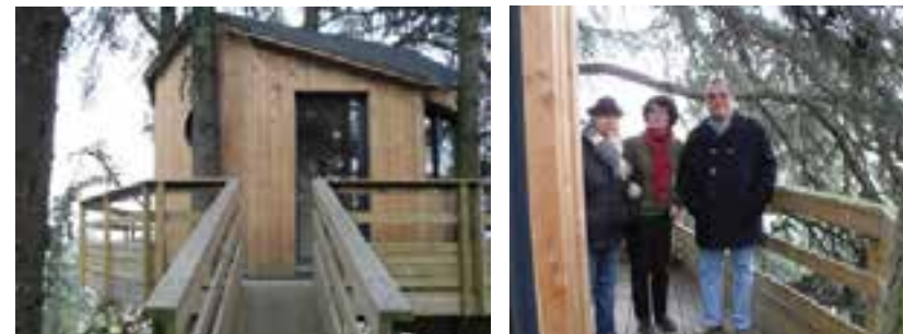
Construction d'une cabane dans les arbres
