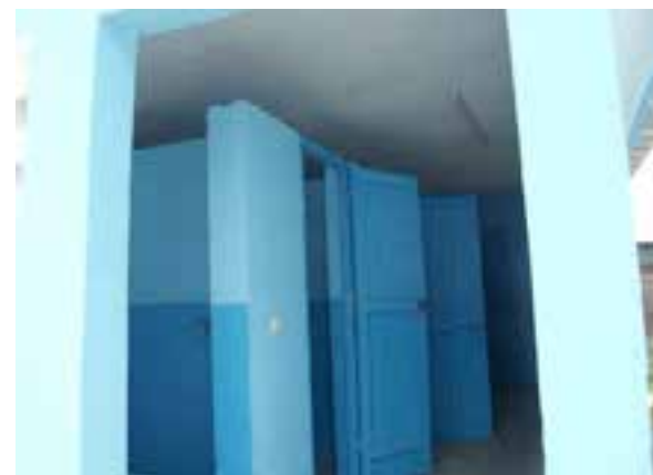
Réhabilitation des toilettes du Collège Moderne BAD de Koumassi.
