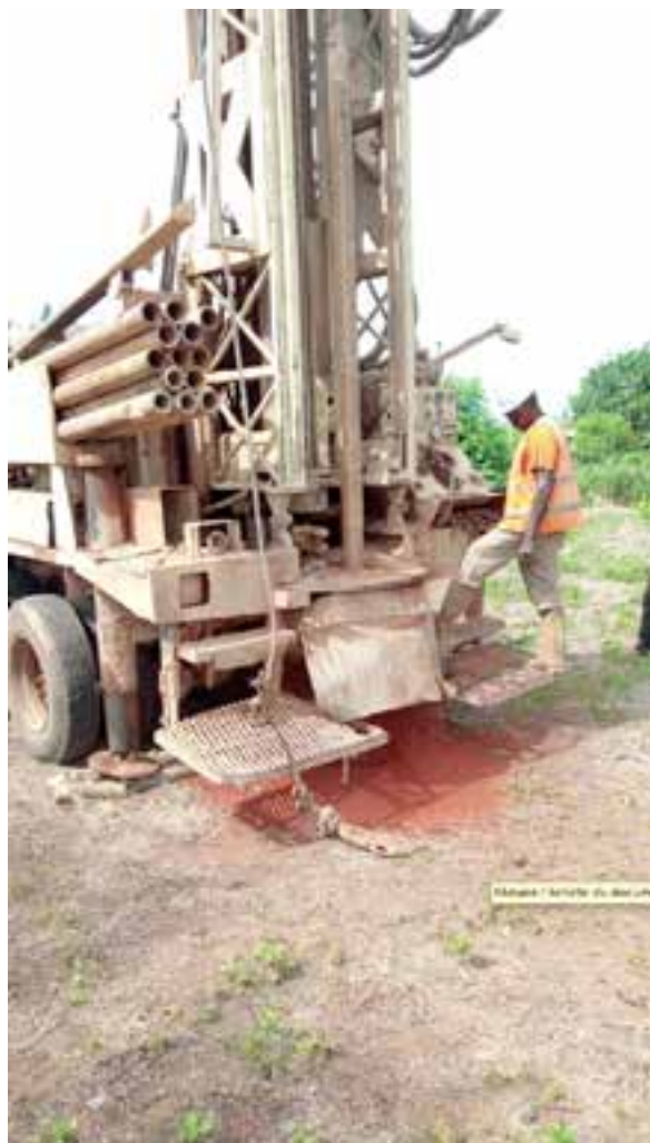
Construction du forage de la maternité du Centre de Santé Rural de Guibérova.
