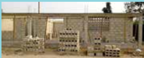
Évolution des travaux en cours
